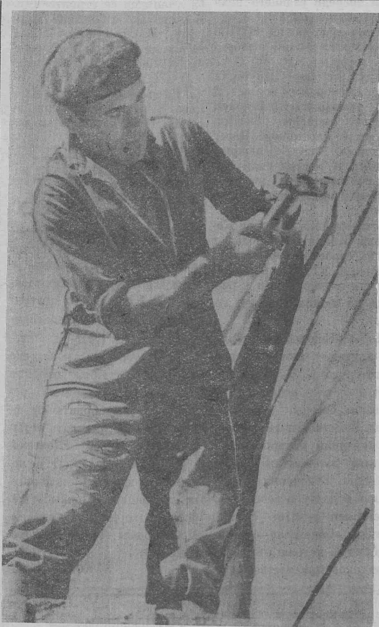
Вакуум-насосная станция — последний пусковой объект второй очереди комбината. Трудятся здесь бригады Геннадия Муромцева, Василия Плащука и звено монтажников Горностаева.
