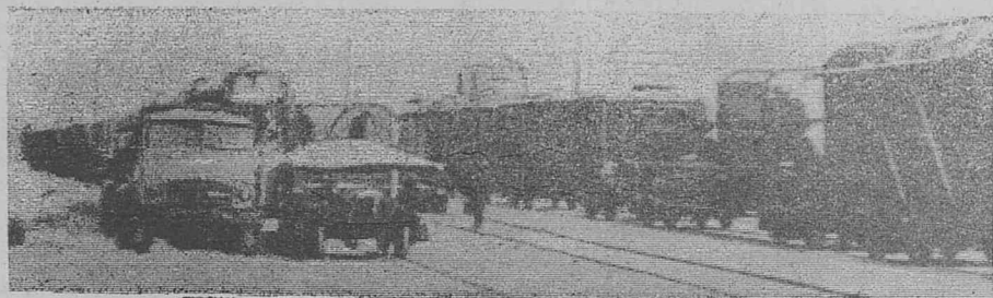
НА СНИМКАХ: расчистка трассы (вверху). На станции Хребтовая.
