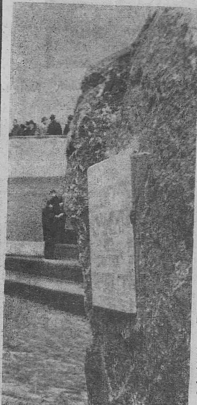
Здесь будет воздвигнут монумент в честь строителей Братской ГЭС — гласят золотые буквы на морской доске, прикрепленной к многотонной диабазовой глыбе. Больше десяти лет отделяют эту надпись от той, что вывела смелая рука на скале Пурсей: «Здесь будет построена Братская ГЭС». Но и та, и другая на века войдут в историю.
