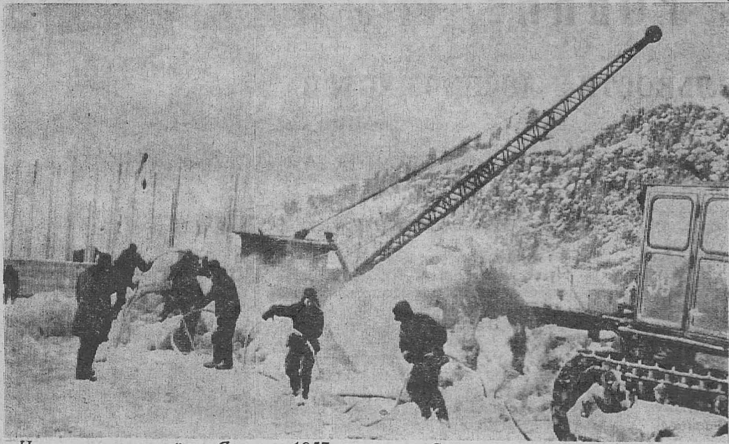
Из летописи стройки. Январь 1957 года. Сооружение продольной рязево́й перемычки. Фото Н. Перка.
