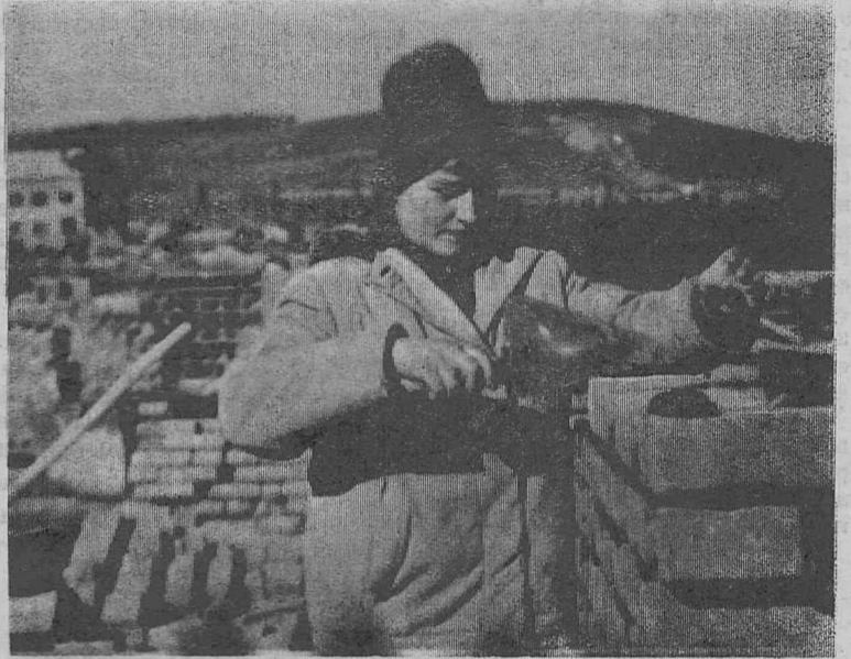
На снимках: каменщики Анатолий Росляков и Лена Смирнова. Идет кладка первого этажа 129-квартирного дома № 10 в шестом микрорайоне. Фото автора.
