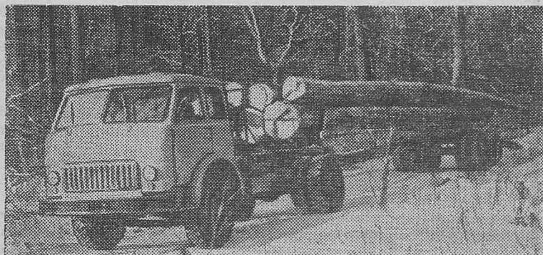
Леспромхозы Приморского края получили за последнее время много новой техники. Сюда пришли мощные тракторы, лесовозные машины, погрузочные краны. Хорошо зарекомендовал себя в работе лесовоз «МАЗ-500». Он обладает большой грузоподъемностью, повышенной проходимостью, хорошо преодолевает крутые подъемы.
