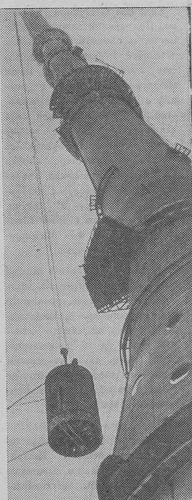
**МОСКВА.** Монтажники Останкинской телевизионной башни произвели подъем первой 23-тонной секции, являющейся основанием металлической антенны, которой увенчается высочайшая башня мира. Поднята также вторая секция. После подъема остальных частей антенны высота телебашни достигнет 533 метра.
