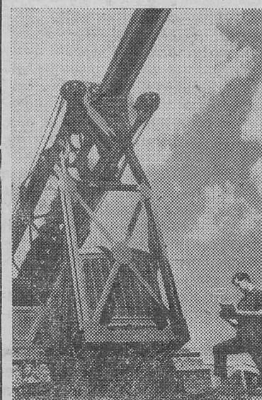
Иваново. Эта мощная машина, напоминающая ракетную установку, предназначена для самой мирной работы — строительства жилых домов повышенной этажности на свайных фундаментах. Она спроектирована и построена на механическом заводе «Главэнергостроймеханизация» по заказу ленинградских строителей. Машина модели МРК-4тм (машина для рытья котлованов) может за несколько минут вырыть котлован глубиной пять метров при диаметре 650 миллиметров.
