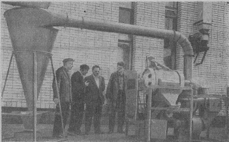
На этом снимке — один из экспонатов ВДНХ СССР — семяочистительная машина ЭМС-1а. Она создана на Воронежском заводе сельскохозяйственного машиностроения. Конструкторы использовали оригинальный способ удаления сорных растений с помощью электромагнитов. Этот эффективный технический метод применяется для очистки семян льна, клевера и люцерны от таких трудноотделимых сорняков, как повилика, василек, плевел, смолевка.
