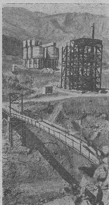
**КИРГИЗСКАЯ ССР.** Скоро начнется укладка бетона в тело плотины строящейся Токтогульской ГЭС. Чтобы удовлетворить нужды стройки в бетоне, здесь сооружается крупнейший завод. Его мощность — два миллиона кубометров бетона в год.
