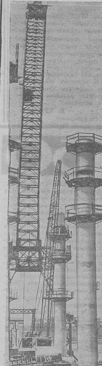
В Уфе строят мост через реку Белую. Он свяжет город с северными нефтяными и сельскохозяйственными районами Башкирии. По мосту пойдут автомашины и трамваи. Длина его 840 метров, а средний судоходный пролет будет равен 130 метрам.
