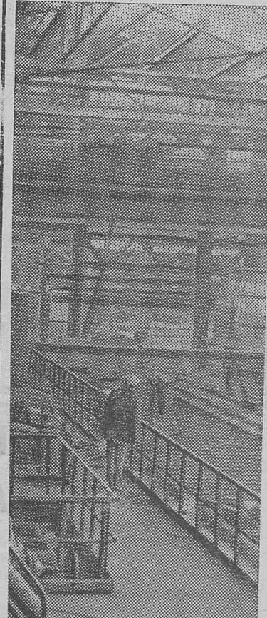
**ДНЕПРОПЕТРОВСКАЯ ОБЛАСТЬ.** На заводе имени Дзержинского в Днепропетровске сооружается мощный прокатный стан «350». Он будет выпускать фасонные профили проката. Технологическая линия предельно насыщается автоматикой и телемеханическими устройствами. Строительство стана ведется ускоренными темпами.
