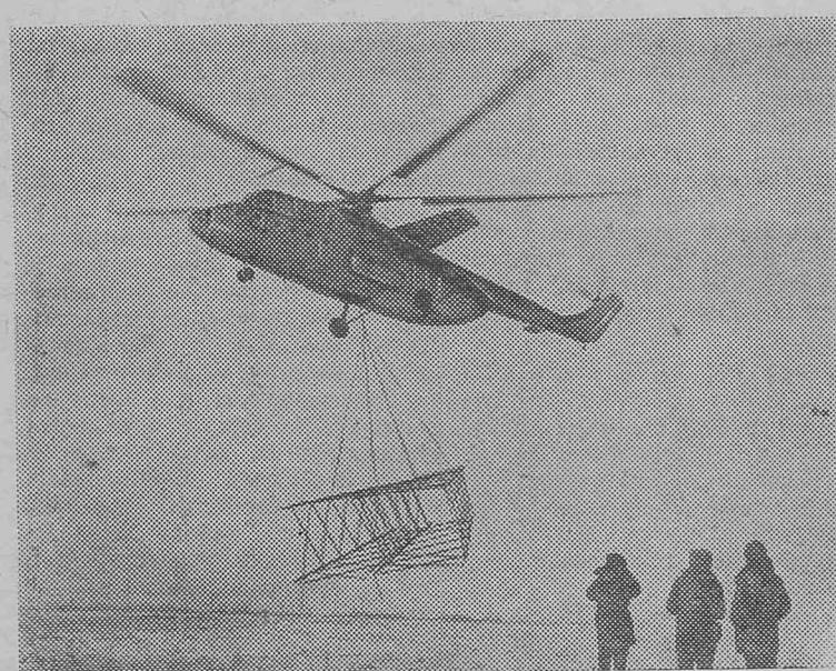
**ТЮМЕНСКАЯ ОБЛАСТЬ.** На строительстве высоковольтной линии электропередачи Тюмень — Сургут для транспортировки многотонных секций опор широко используются вертолеты «МИ-6».
