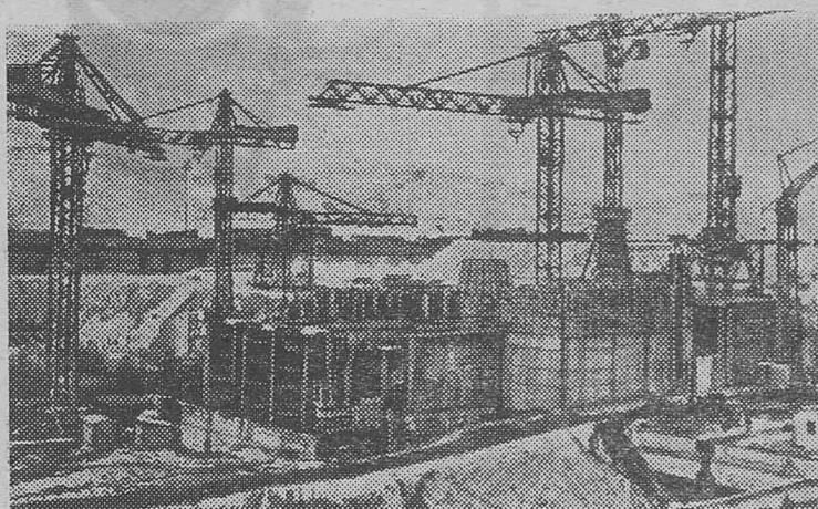
В районе ущелья Джердап на Дунае (на границе между Румынией и Югославией) сооружается одна из крупнейших в мире гидроэлектростанций мощностью 2000 мегаватт (с ежегодным производством 10,432 миллиона киловатт-часов электроэнергии) и судоходная система, в результате которой пропускная способность в этом месте возрастет в 4 раза.
